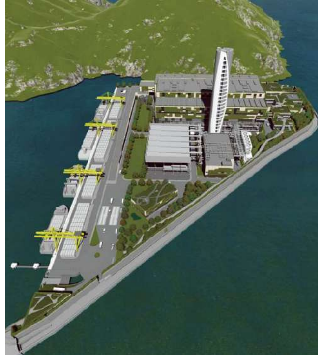
Shek Kwu Chau Incinerator Works 石鼓洲焚化爐工程
