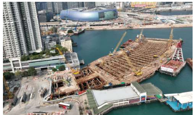
Central Kowloon Route - Kai Tak West Tunnel 中九龍幹線-啟德西隧道
