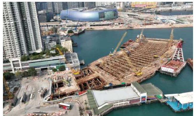
Central Kowloon Route - Kai Tak West Tunnel 中九龍幹線-啟德西隧道
