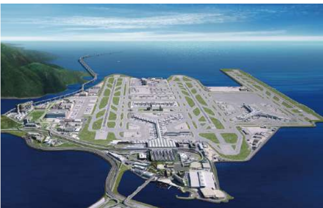
Hong Kong International Airport Three-Runway Terminal Building 香港國際機場三跑道客運大樓
